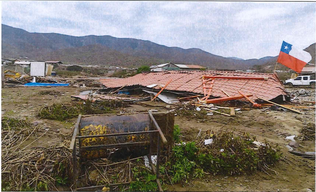
Vivienda en cauce con daño total por flujo. Figura D del Reporte Técnico Sernageomin 2026.
