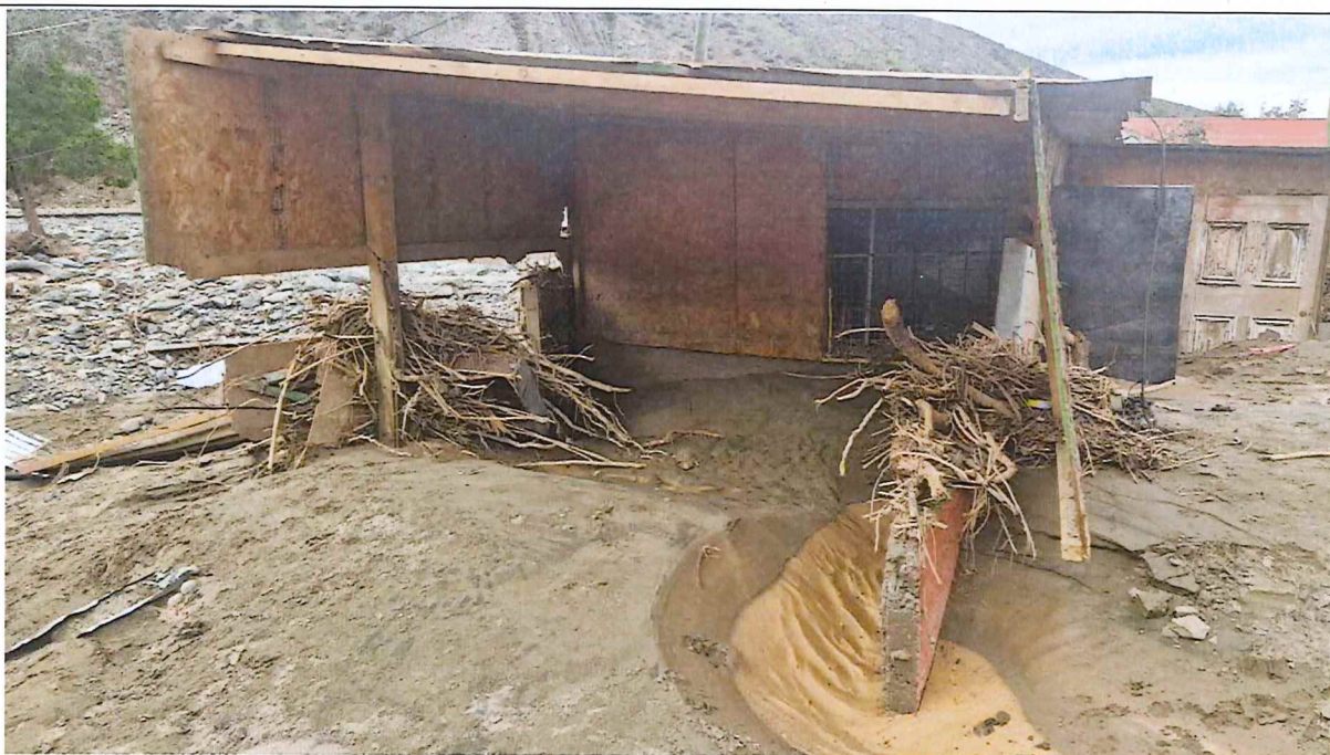
Foto vivienda destruida Pueblo El Islón. Evaluada por profesionales del MINVU al aplicar Ficha 2. Fecha 24 de julio 2026
