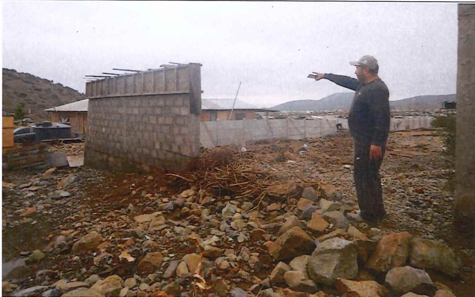
Sitio con depósito de flujo de detritos desbordado de la quebrada original, destruye muros y daña sitios agua abajo. Figura I Informe Técnico Sernageomin
