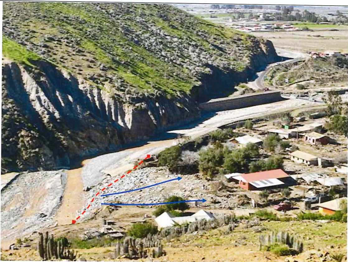
Fotografía vista este, se muestra donde el caudal rompió la contención de gaviones, flechas azules indican dirección de ingreso de flujo hacia la zona poblada.
