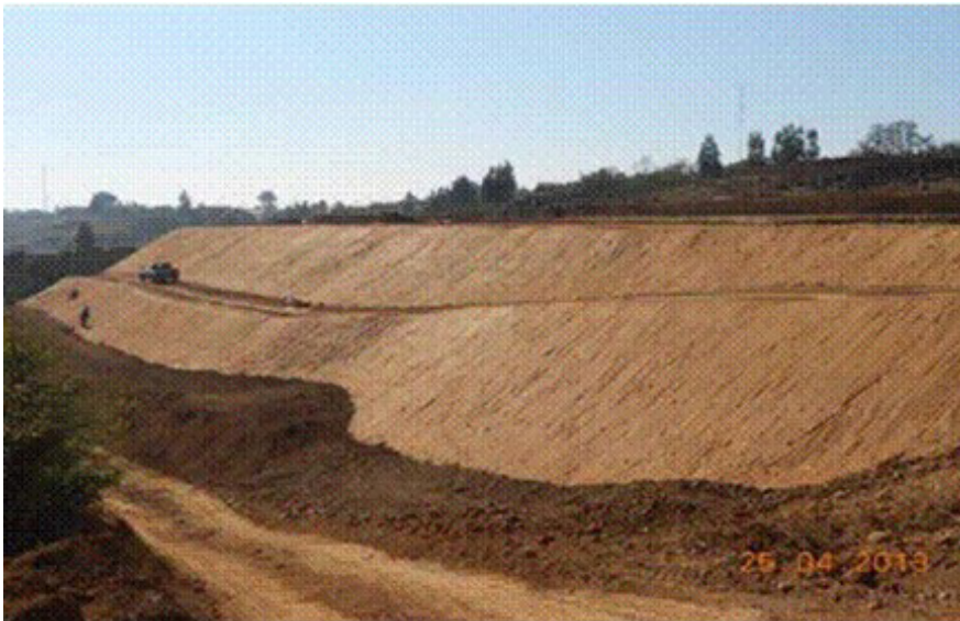
← Figura 49: Manta de Control de Erosión Temporal Fibra de Coco. (Fuente Emin)
