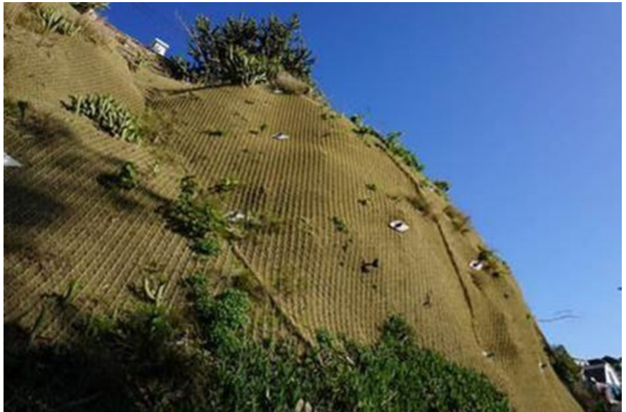
Figura 44: → Talud estabilizado superficialmente en Av. La Marina Cartagena (Fuente: Geobrugg)
