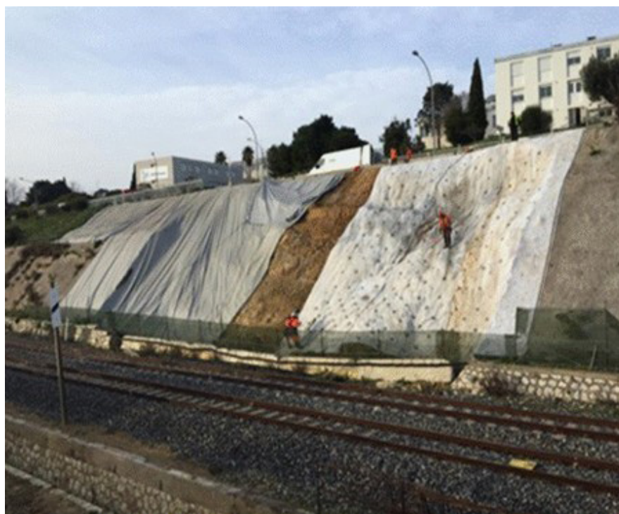
← Figura 43: Manto de Hormigón | Compresión 80 [MPa] (Proyecto en Francia) (Fuente: Emin)
