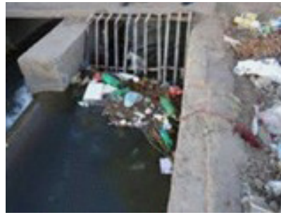
← Figuras 50: La imagen muestra dos rejas de retención de basuras. (Fuente: Ricardo Luna)
