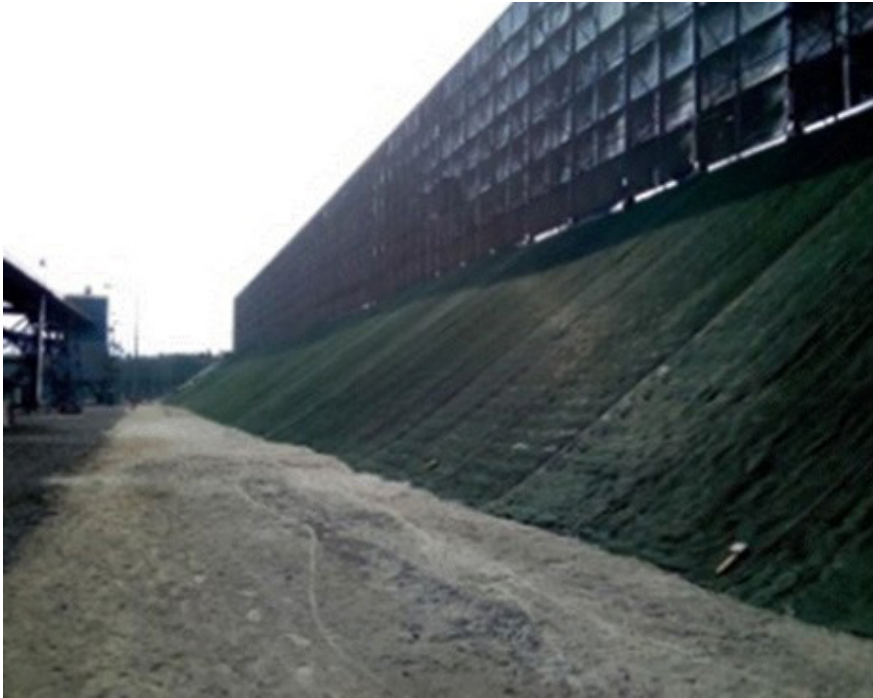
← Figura 48: Mantas de Control de Erosión Permanentes TRM (Turf Reinforcement Mat / Esterilla de Refuerzo de Vegetación) (Fuente Emin)
