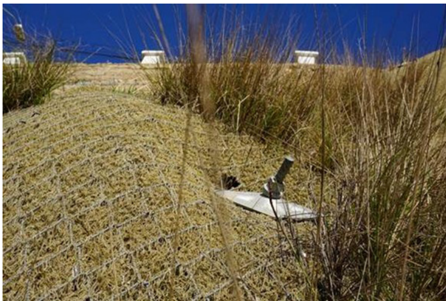
Figura 47: → Geomalla termofusionada (TECCO GREEN) (Fuente: Geobrug)
