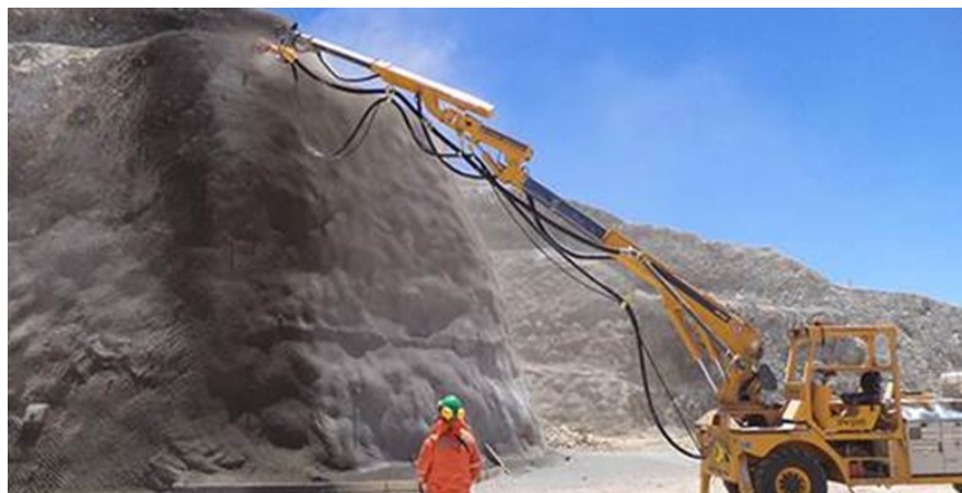
← Figura 42: Talud con shotcrete (Fuente: Putzmeister)
