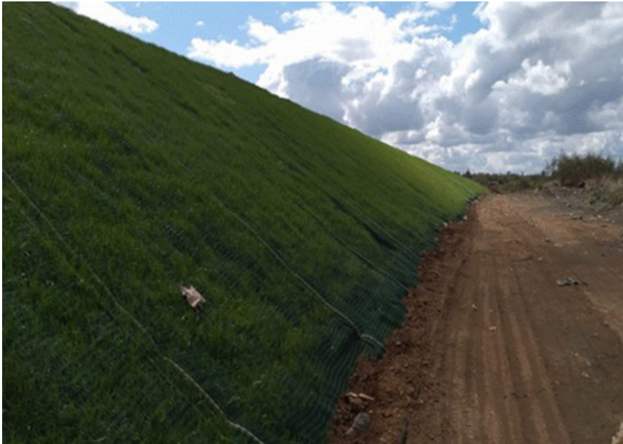
← Figura 46: Hidrosembrado sobre el talud (Fuente: Emin)
