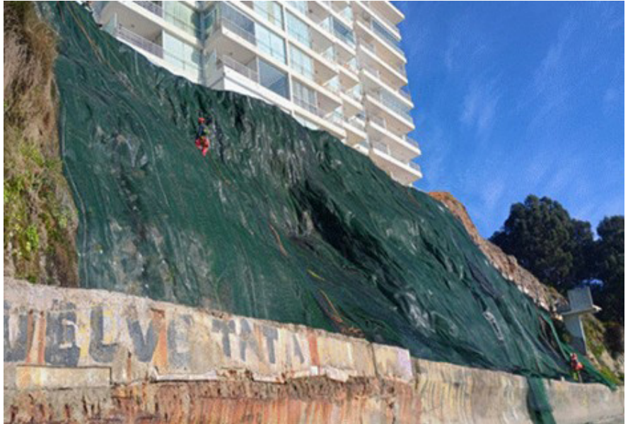
Figura 45: → Sistema Vegetalizado de Malla Reforzada Anclada. (Fuente: Emin)
