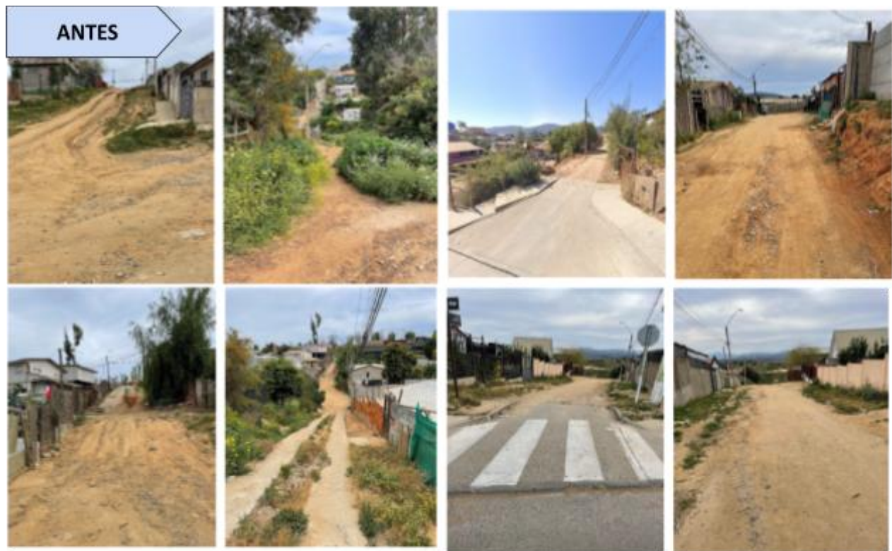
Situación previa a las obras. Conservación de pavimento, Pompeya Sur, Quilpué
