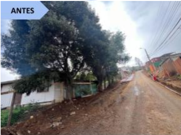
Ejecución de Obra Calle Los Helechos, Lomas
