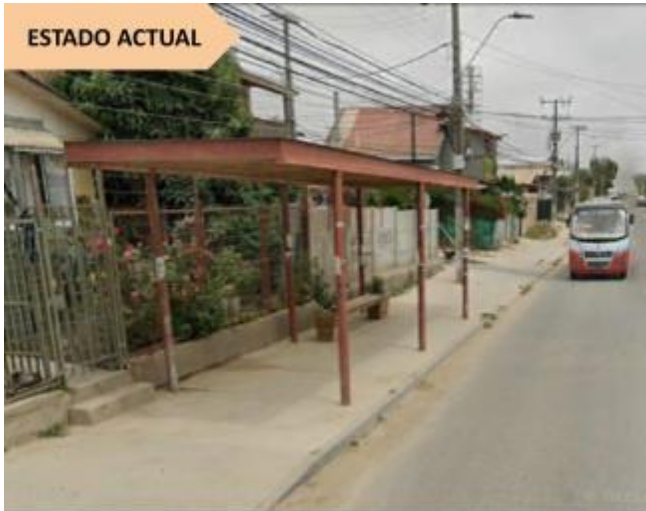
Estado actual paradero Pompeya Sur, Quilpué
