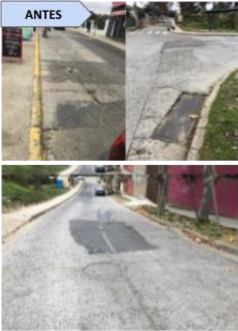
Situación previa a las obras. Conservación de pavimento, Canal Chacao, Quilpué
