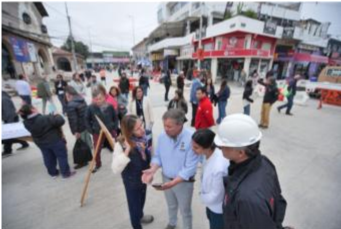
Avance de obras Mejoramiento Paseo Los Héroes y veredas adyacentes
