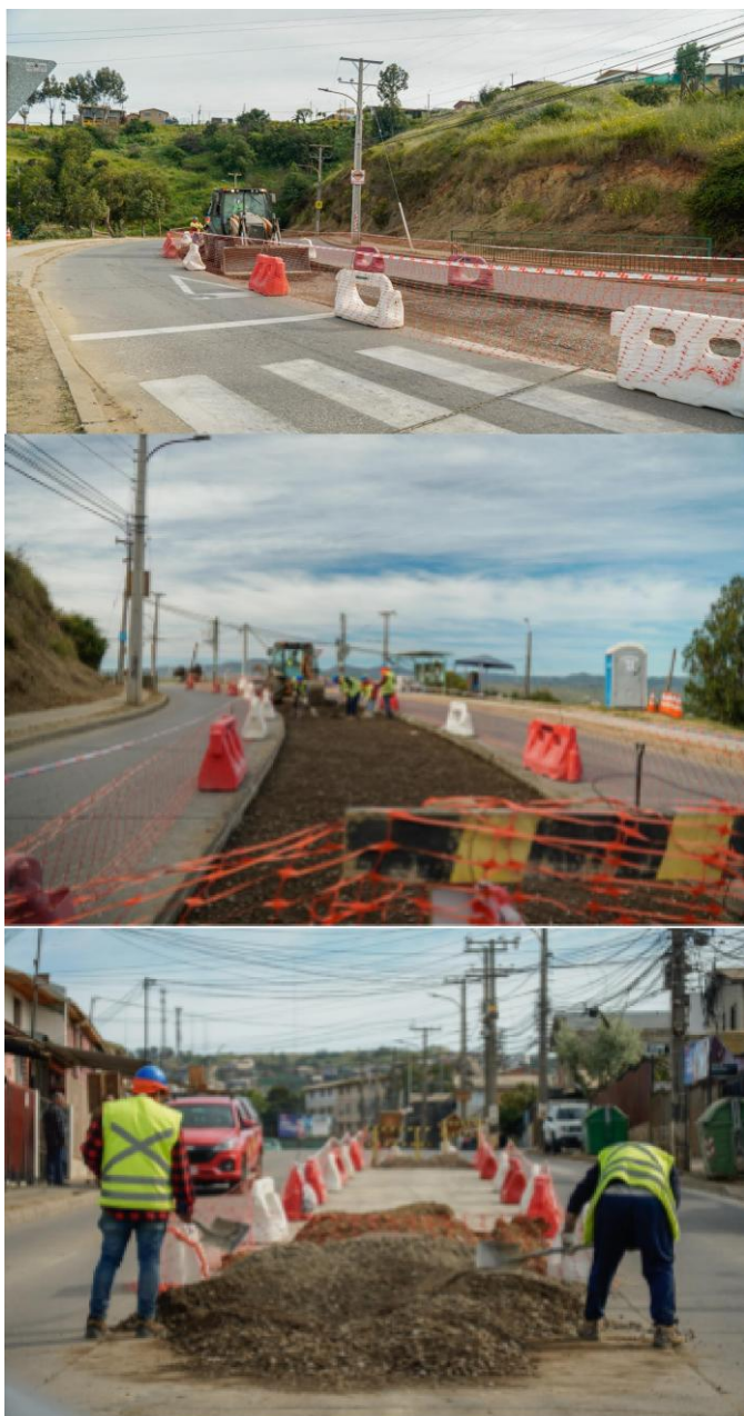
Inicio de Obra Av Tamarugal, El Olivar.
