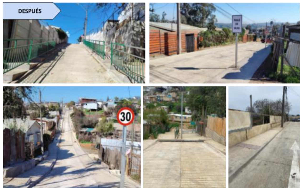
Obra Terminada. Conservación de pavimento, Pompeya Sur, Quilpué
