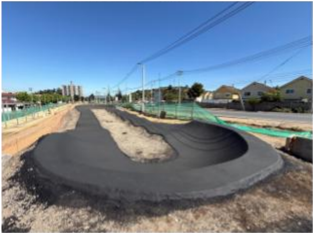
Avance de obras. Plaza Los Pasionistas
