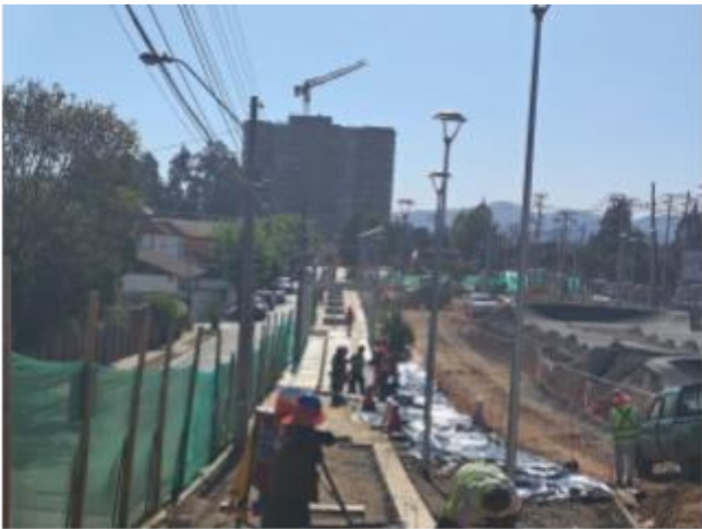
Avance de obras. Plaza Los Pasionistas
