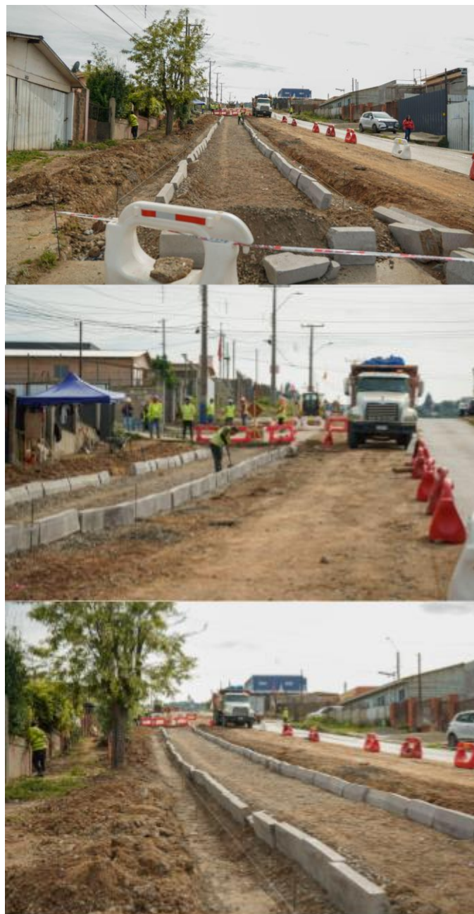
Inicio de Obra Augusto D'halmar, Villa Independencia.
