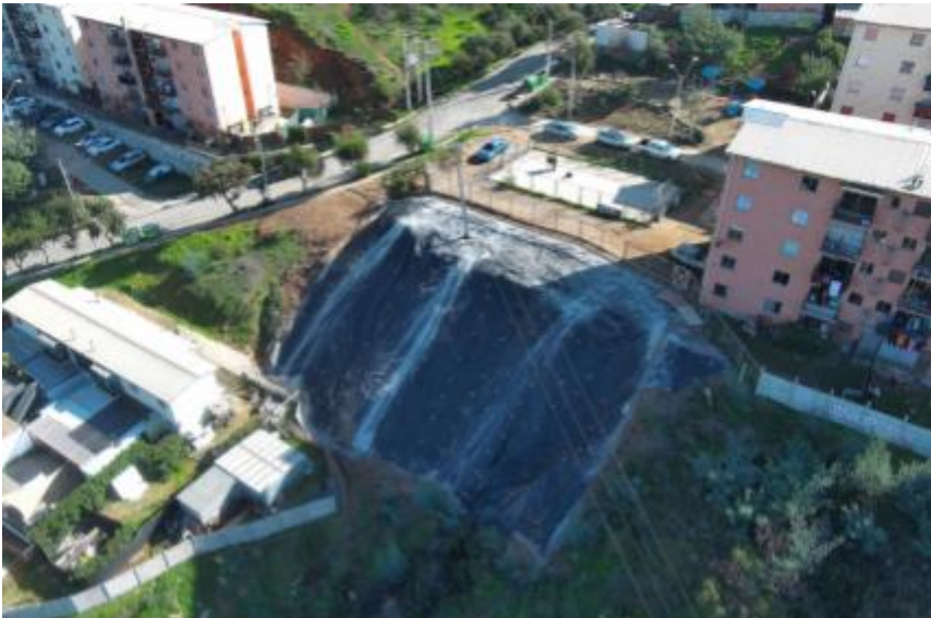
Obra terminada, mitigación de emergencia, condominio Santa Sonia.
