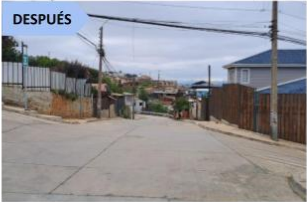
100% Avance físico de Obra Calle Los Lirios, Lomas Latorre.
