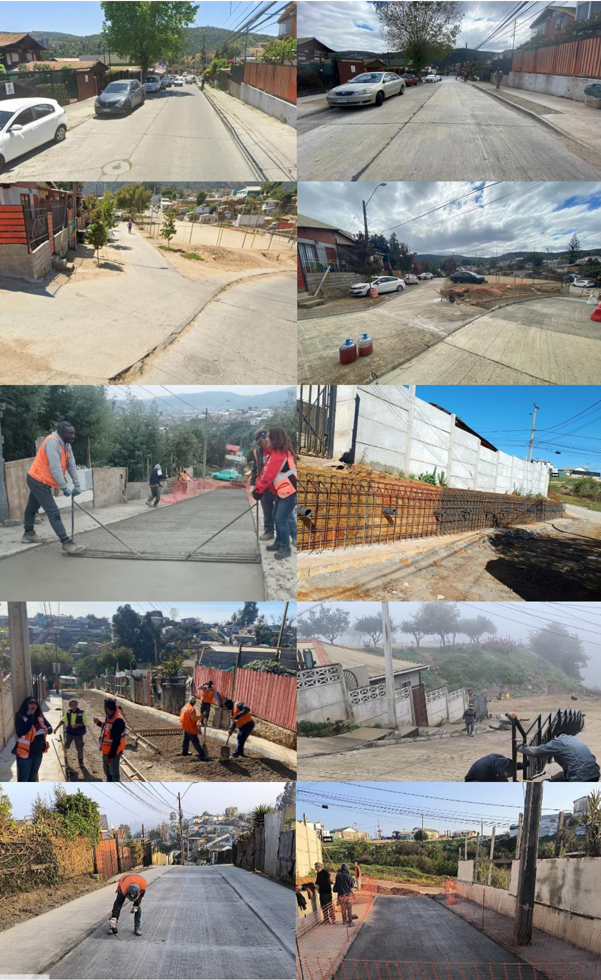
Antes / Después. Pavimentación Pasaje Tres, Población Argentina. (en ejecución, 99% avance)
