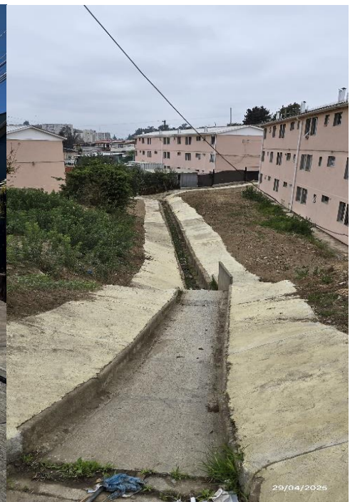
Conservación de Aguas Lluvias, Estero, El Olivar, 100% terminada
