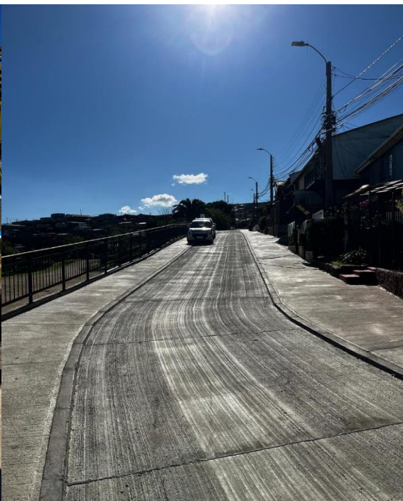
Pavimentación Pasaje Dupliza El Olivar Norte, 100% terminada
