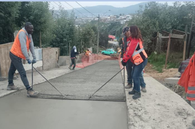
Pavimentación Pasaje Angamos, Pompeya
