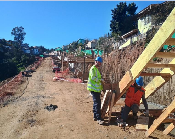
Pavimentación campamento Manuel Bustos
