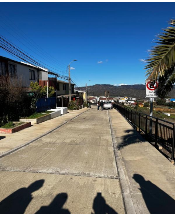
Pavimentación Pasaje Pisagua El Olivar Norte, 100% terminada
