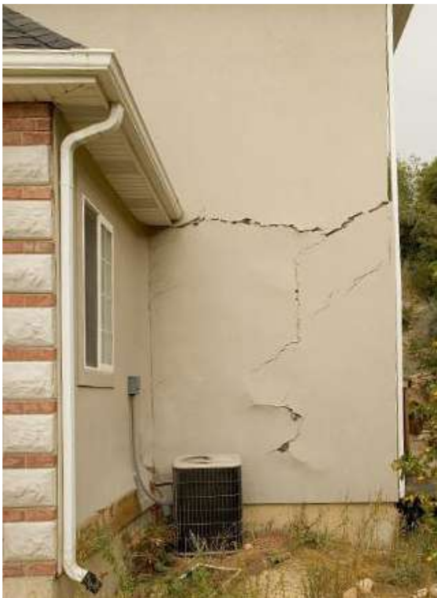
← Figura 1.3: Daño en vivienda debido a arcillas expansivas (Colorado, EE.UU.).(www.staufferandsons. com)
