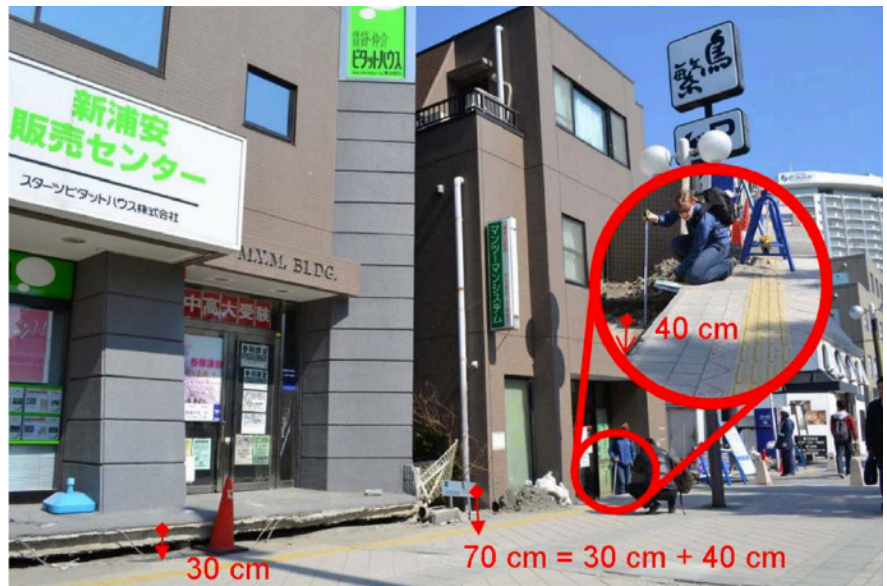
↑ Figura 30: Diferentes niveles de asentamientos según distintos sistemas de fundaciones. A la izquierda edificio sobre pilotes, mientras que a la derecha, se muestra el nivel de asentamiento de un edificio sobre fundaciones superficiales con respecto al campo libre (Ashford et al., 2011).
