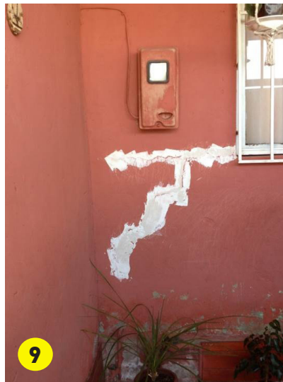
← Imagen 8, 9 y 10: Grieta muro.
