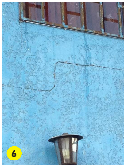
← Imagen 5 y 6: Grietas producto de asentamientos.
