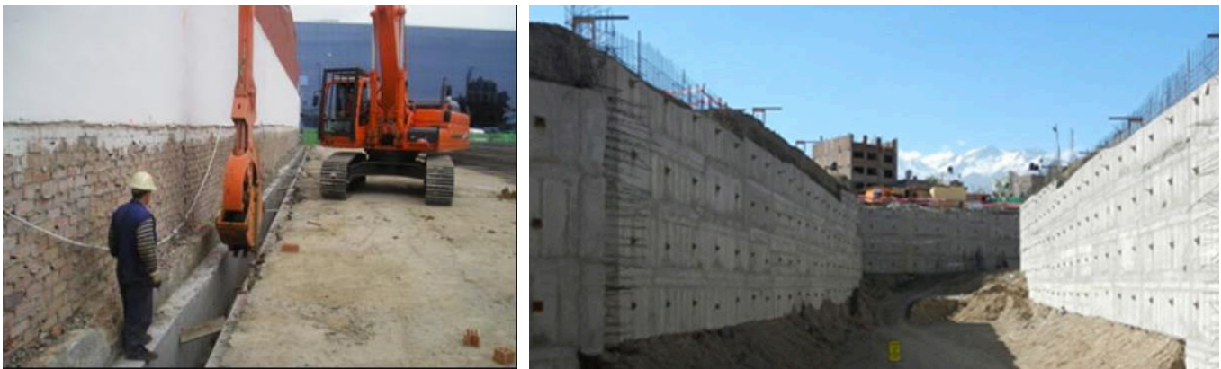
↑ Figura 10.1. Muro pantalla. A) sistema autoportante (Yepes, 2016). B) sistema arriostrado (Construproductos, 2018).
