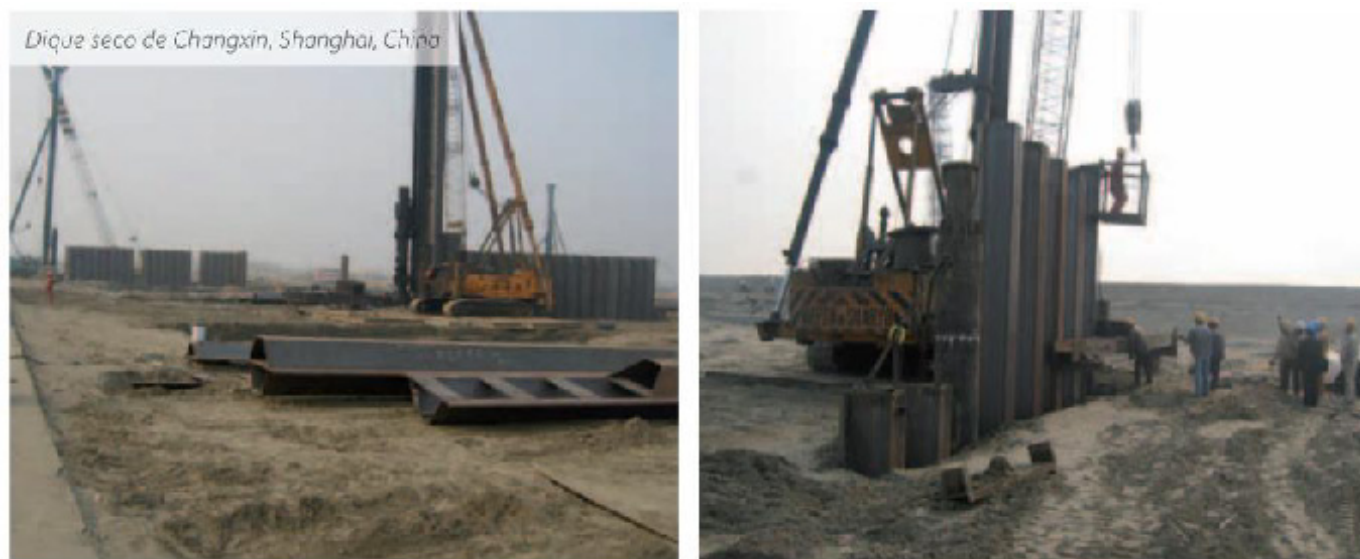
↑ Figura 13.13. Hincado de Tablestacas (AcerlorMittal, 2010).
