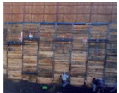
Paso 4: Instalación y vigas de amarre
