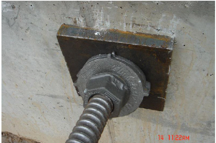
..... Figura 9.6. → Estructura de un tendón tipo barra (Suárez, 2009)
