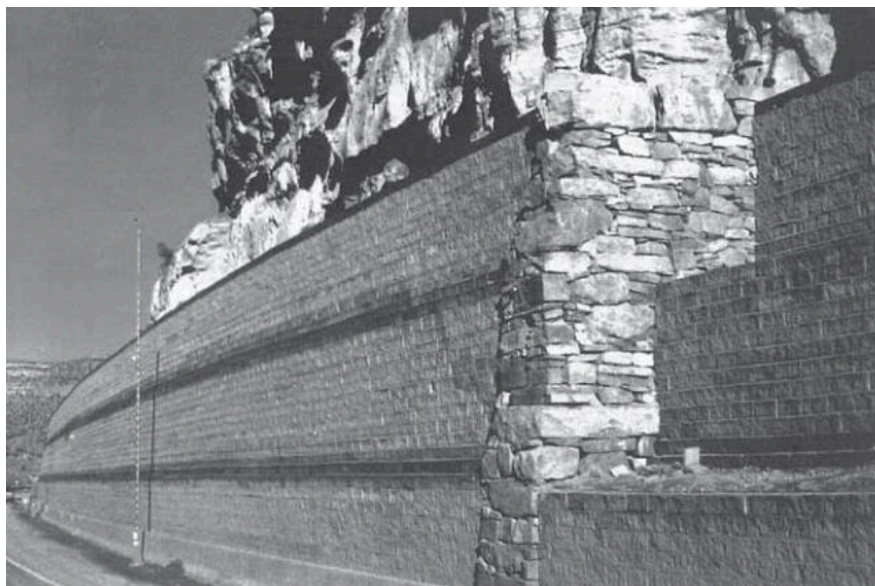
..... Figura 12.8. → Ejemplo muro de tierra estabilizados mecánicamente con geosintéticos (Braja, 2012).
