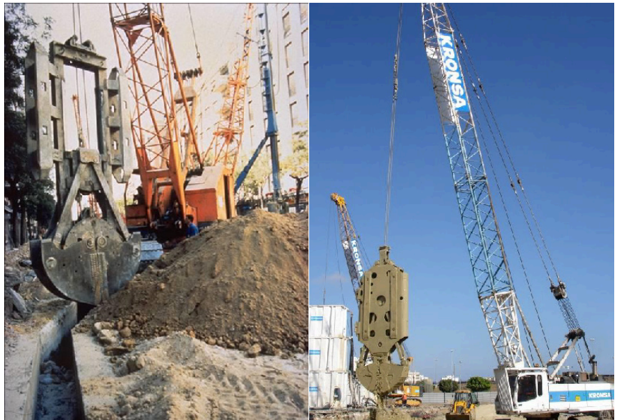
Figura 10.6. → a) cuchara de cable (Murete, 2018).
