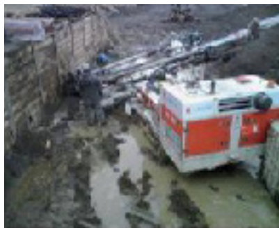
Paso 3: Perforación y colocación de anclajes
