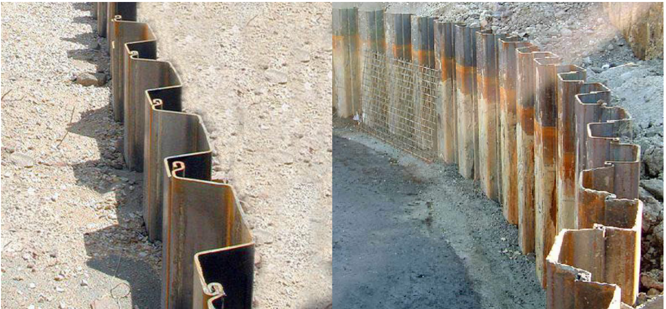
↑ Figura 13.1. Ejemplos de Tablestacas metálicas (Yepes, 2016).
