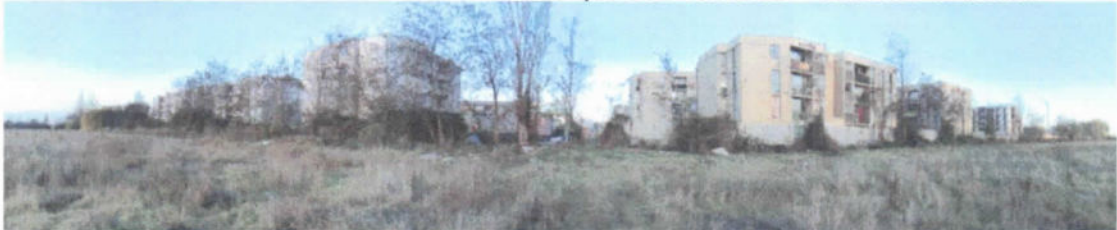
Vista sur oriente
