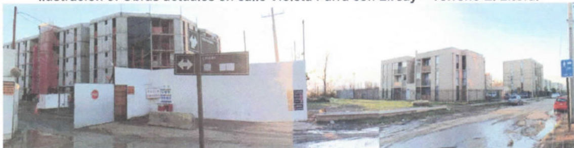
Ilustración 5: Obras actuales en calle Violeta Parra con Lircay – Terreno El Litoral
