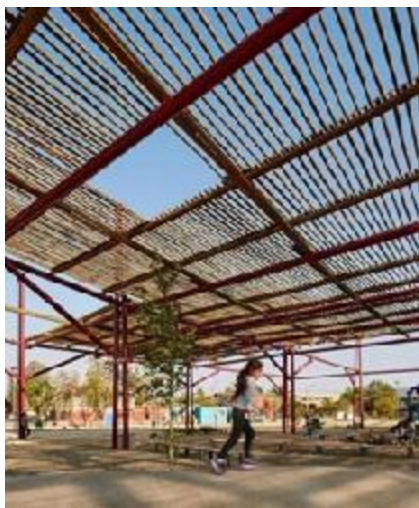
Figura N° 15: Ejemplo de infraestructura para el sombreadero en el espacio público.
