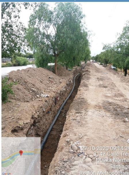
**Tramo I y tramo II: Nos encontramos en la etapa de mejoramiento de suelos para pavimentos de terminación. Además estamos trabajando en la instalación de las redes sanitarias, eléctricas y de riego.**
