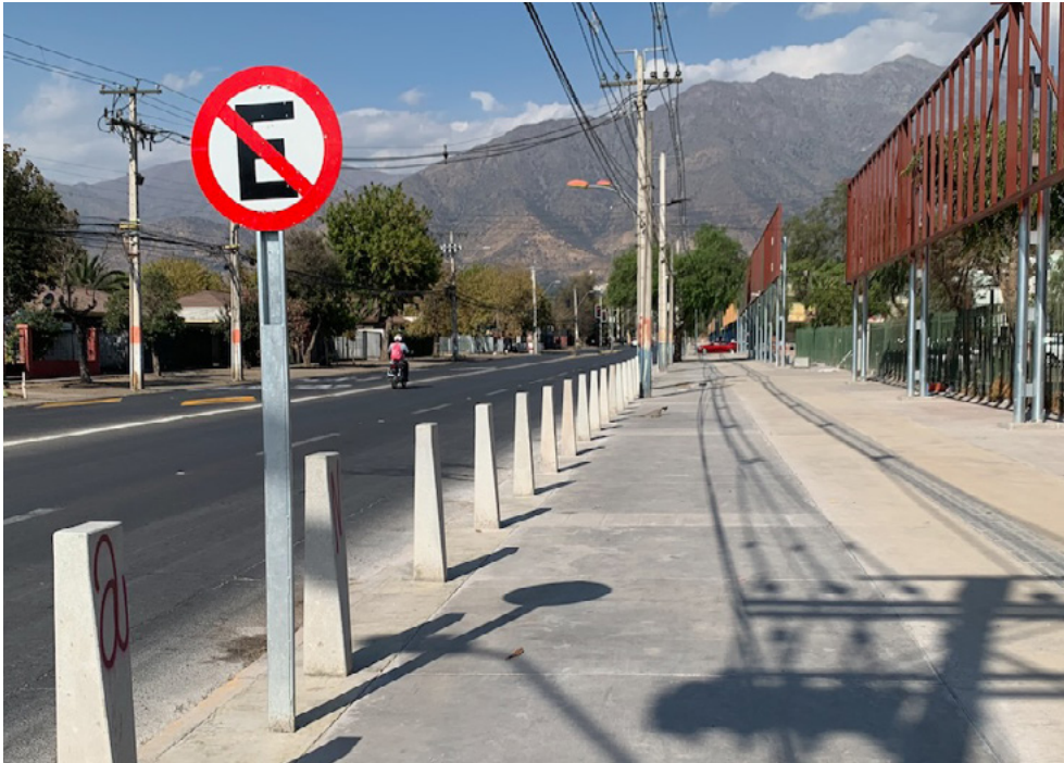
Figura 35: Protección de aceras con bolardos de concreto. Sin embargo en esta foto de ejemplo, los bolardos carecen de contraste con la vereda, característica necesaria para la accesibilidad de las personas ciegas o de baja visión. Av José Arrieta, Peñalolén.
