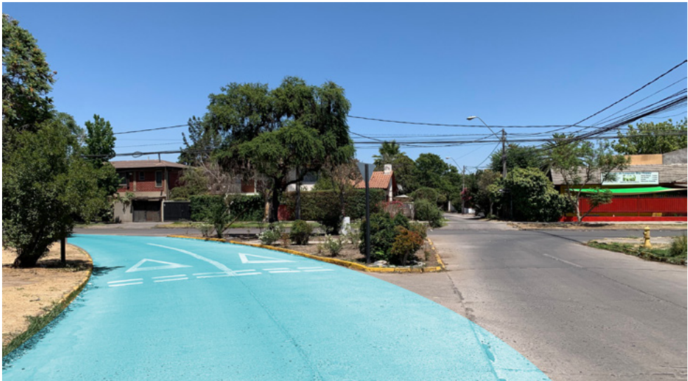
Figura 8: El remanente de calzada está en las pistas de incorporación y amplio radio de giro, la que podría ser eliminada, dejando una intersección en cruz con cruces peatonales accesibles y demarcados. Se puede ampliar la zona verde en acera generando una pequeña plaza.
