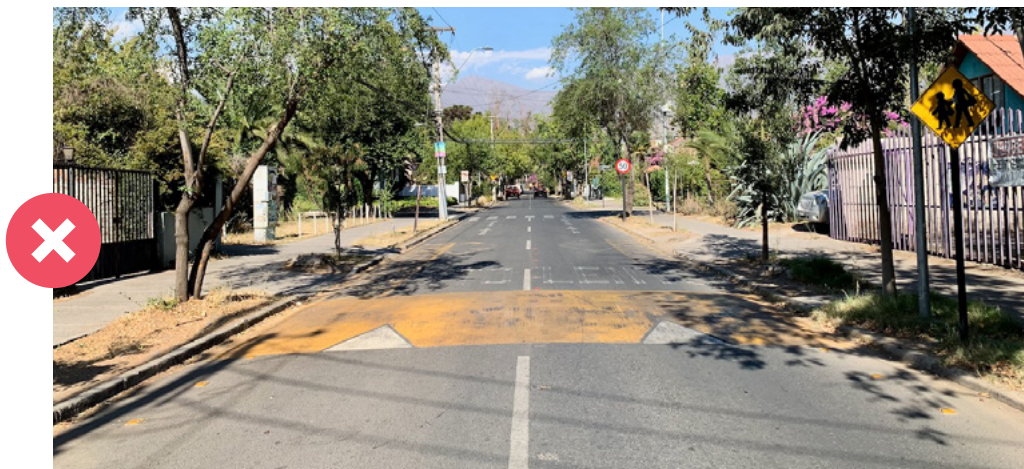
Figura 17: La fotografía muestra un lomo de toro ubicado antes de un paso peatonal, pero se colocó una señal de límite de velocidad de 50 km/h después del lomo de toro y justo antes del paso de cebra. Es justamente en ese punto donde se debe reducir la velocidad. En este caso, la instalación de un cruce peatonal a nivel de vereda (acera continua) resultaría más adecuado, junto con un límite de velocidad menor a 30 km/h.
