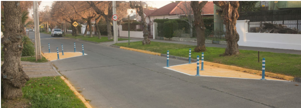
Figura 32: Módulo táctico de chicanas de paso alternado en vía de 6 a 7 m de calzada. Imagen superior: Providencia. Imagen inferior: Ñuñoa.
