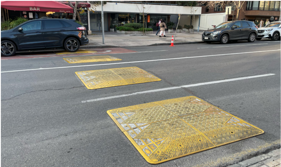
Figura 19: Grupo de cojines en vía de dos pistas por sentido. Cada cojín está instalado al centro de la respectiva pista y los cuatro en el mismo eje transversal a la calzada.
