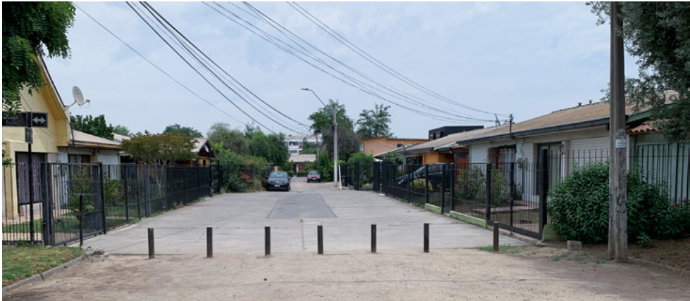
Figura 2: Restricción del paso de automóviles manteniendo la circulación de peatones y ciclos. Ñuñoa, 2025.
