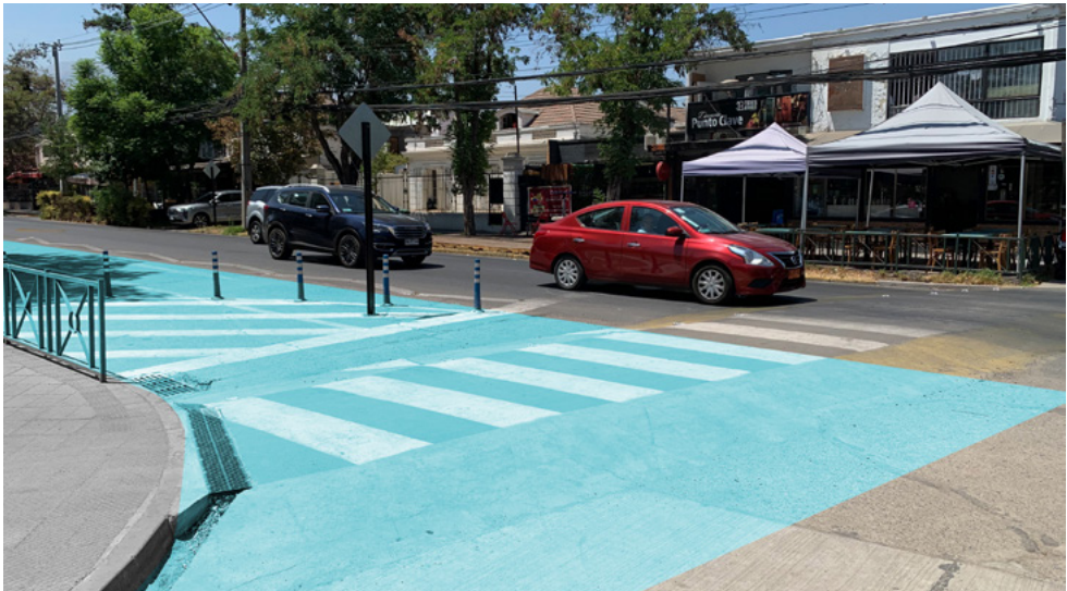
Figura 10: Muestra una intervención simple, de bajo costo y rápida implementación, que incluye demarcación con pintura y bolardos a modo de ampliación de acera. Induce al conductor a disminuir la velocidad al estrechar la pista vehicular y al mismo mejora la visibilidad del peatón al cruzar la calzada. Esta medida puede implementarse con obras permanentes de ampliación de acera.
